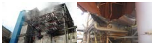
Fotos #1 y 2 Casos de incendio y/o explosión
