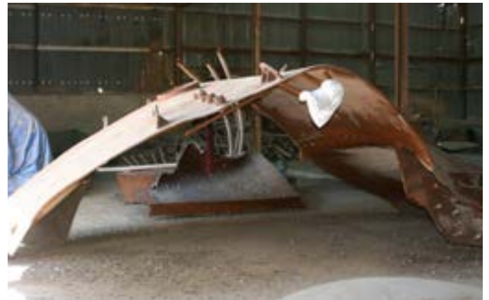
Figura #2. Vista final de una parte a la caldera fallida.
