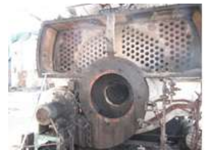
FOTO N°4 – El quemador y ambas tapas de las cajas de humos son expulsadas.
