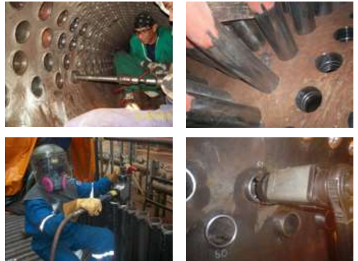
Figura # 4: Vistas varias del proceso de re-entubado
